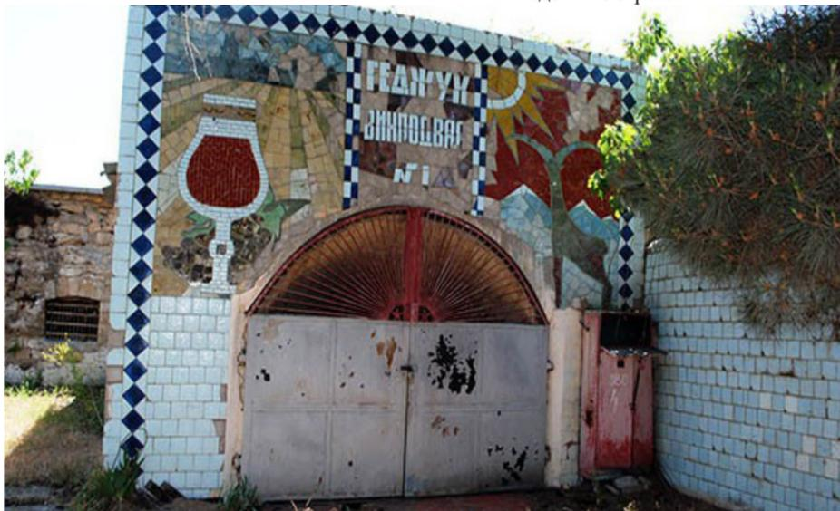
Строили подвалы интересным способом. Был выкопан фундамент, на месте помещений были оставлены бугры в форме половинки цилиндра, которые послужили опорой для выкладки свода стен и потолков. Затем из-под них выгребалась земля и выкладывался пол. Стены и потолок засыпались той же землёй. Строили его каторжане с каменоломен под руководством французского специалиста — винодела по фамилии Бертрэн.
